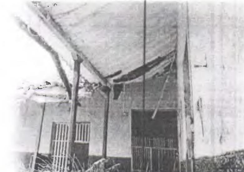
Cubi. en mal estado banaque, vigas y correas de madera en mal estado, canales
