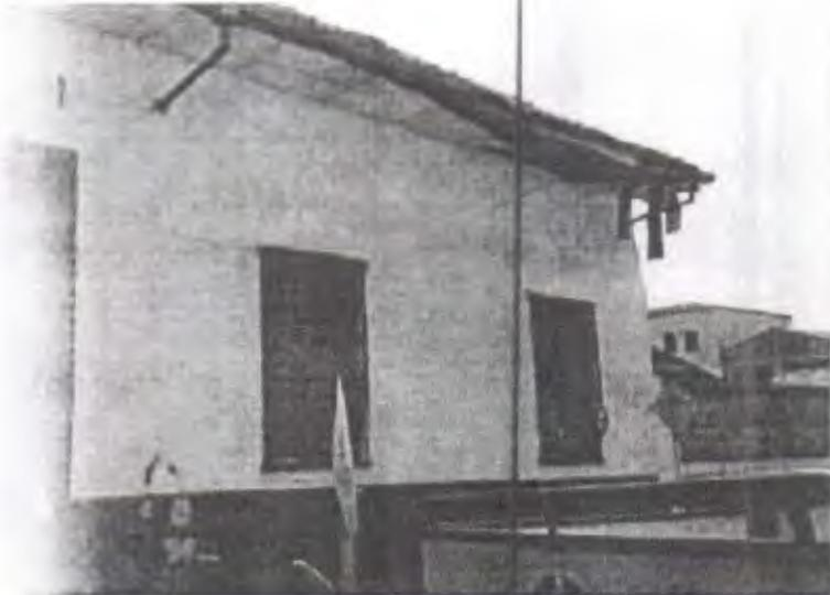
Facilid para en mal estado y ventana por reparar. Cielo raso en alero
